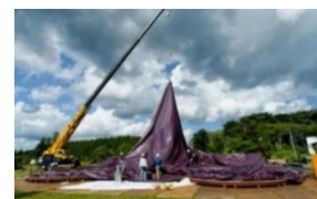
設置中の様子
